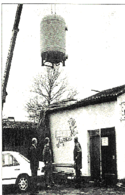
Um die neue Errichtung in Funktionsgebäude des Freibades mit Hilfe eines Kranes platzieren zu können, mußte zunächst das Dach abgedeckt werden.
