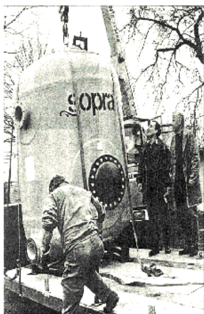
Nach mehrstündiger Anreise aus Sachsen-Anhalt traf gestern Vormittag in Großenvörde die neue und rund sieben Tonnen schwere Filteranlage bei der Freizeitanlage.
